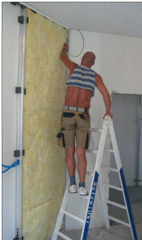
Der Schreiner montiert die isolierten Trennwände im zukünftigen Schalterbereich.
