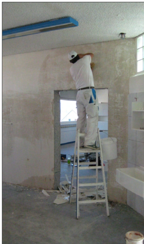
Blick durch die neu ausgefräste Türöffnung ins Gemeinderatszimmer. Inzwischen wurde auch der Tüzzargen gesetzt.
