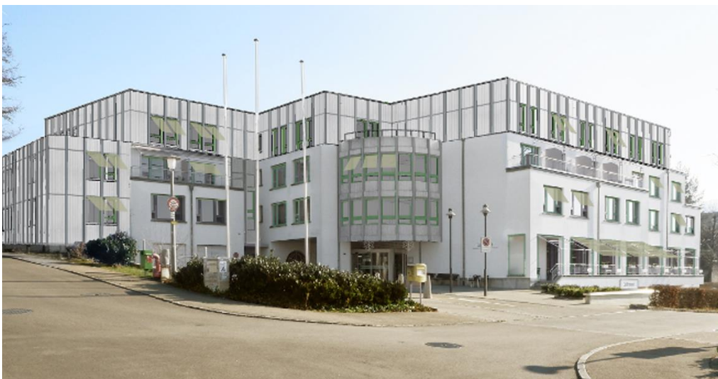
Aussenansicht APH Wollmatt nach Umbau
